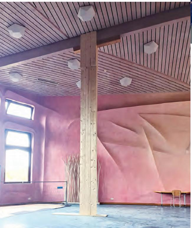
Um Schlimmeres zu vermeiden, wird das Dach aktuell mit einem **massiven Holzträger** provisorisch gestützt.
