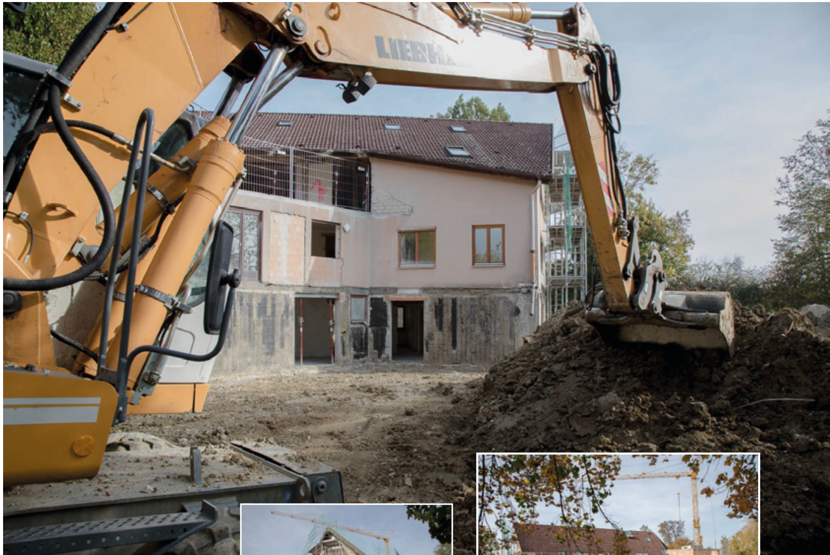
Modernisierung des Grünwaldhauses Fotos: Lennart Vocke
